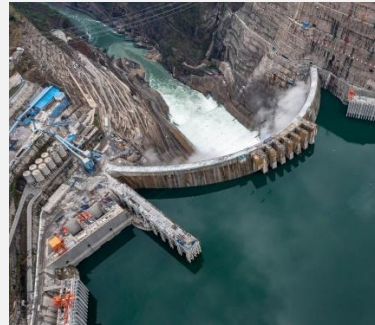
白鹤滩水电站
