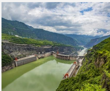
溪洛渡水电站
